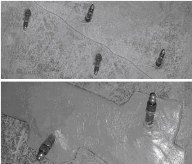
Figur 1 og 2. Injektionsnipler, placeret omkring revnen og forsejlet med den korrekte epoxyklæber.
