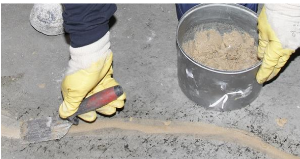
Figur 6. Udjævning af revneoverfladen ved hjælp af den korrekte MasterEmaco-mørtel.
