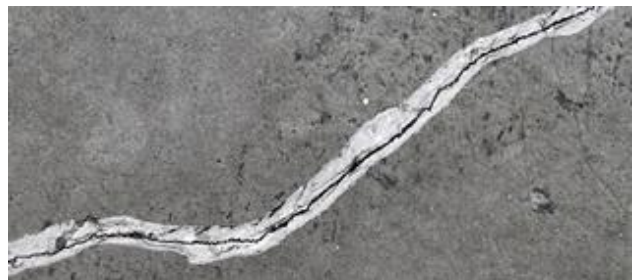
Figur 3. Revneåbningen skåret op i V-formet rille.
