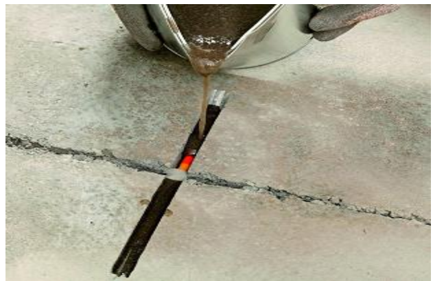
Figur 7. Fyldning af ankerrillerne med MasterInject 1360-blanding.
