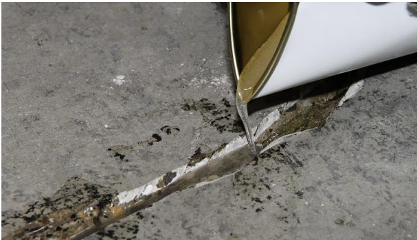
Figur 5. MasterInject 1360 hældes direkte i den V-formede rille, der er skåret i revnen.
